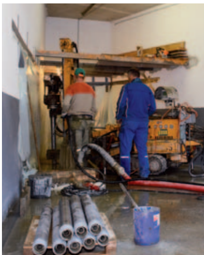
Unterfangungsarbeiten an der südlichen Grundgrenze im Herbst 2016.
